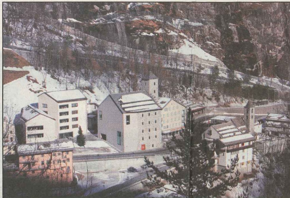
L'hôtel de la Tour Stockalper intégré dans l'ensemble de la nouvelle place centrale de Gondo. LDD
