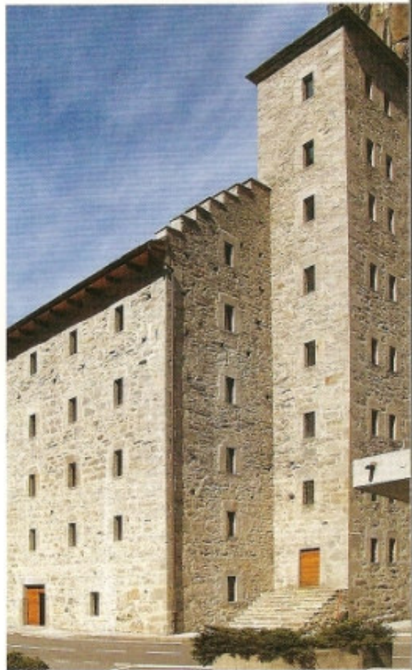
Die Renovation hat dem Stockalperturm in Gondo neues Leben eingehaucht.
