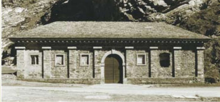
«Alte Kaserne» vor der Renovation im Jahre 2000
